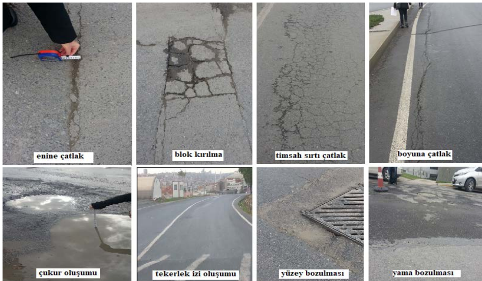
Şekil 4. Kesimlere ait bozulma örnekleri
