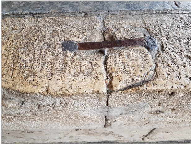
Şekil 1. Mevlana Müzesinde bulunan yığma taş bloklar üstündeki kenet uygulamaları
